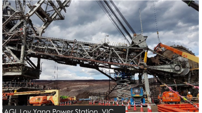
AGL Loy Yang Power Station, VIC
