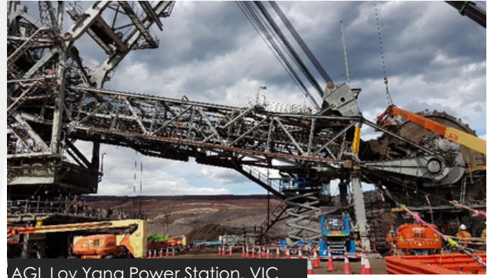
AGL Loy Yang Power Station, VIC
